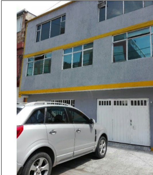
Fotografía N°. 1 Fachada del predio.
